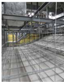
天井裏の様子
