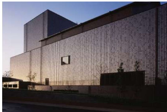
図3 | グラントワ大ホール外観、写真左手の高い部分がフライタワー
